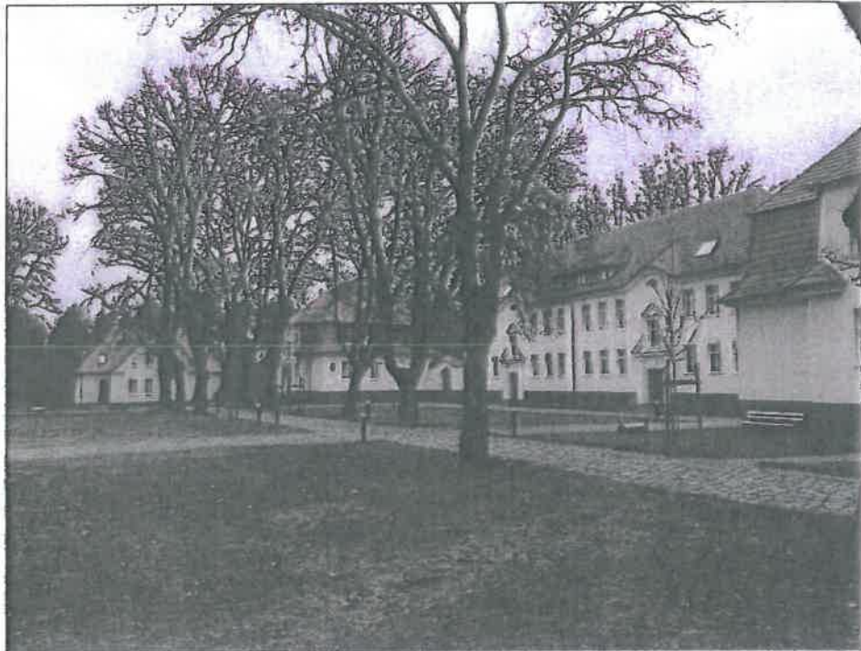
Abb. 3 ehemalige Offizierswohnhäuser Ahornring, Blick von Süden
