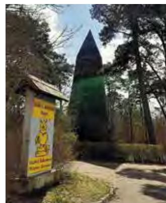
Auf dem Bunkeranlage
