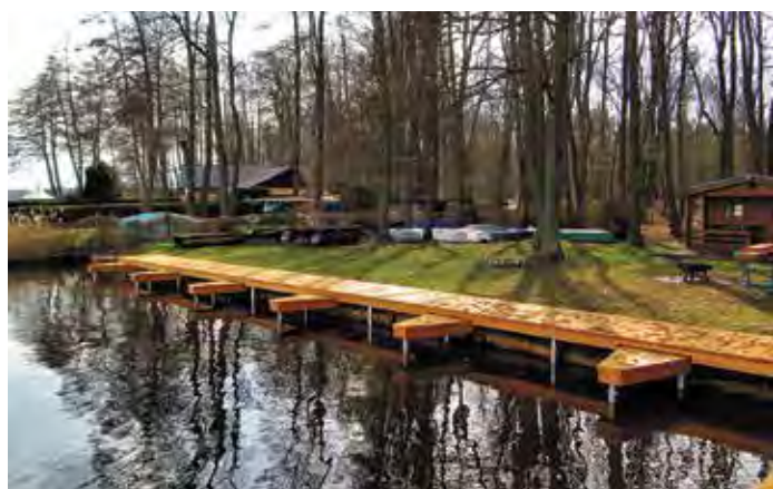
Neue Steganlage des Angelvereins Schöneiche e. V. am Motzener See in Kallinchen
