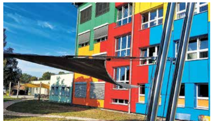
Das erste Sonnensegel wurde gesetzt.
