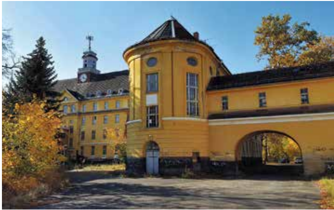
Das Gebäude der 1914 bis 1916 errichteten Militärturnanstalt (Aufnahme 2018)
