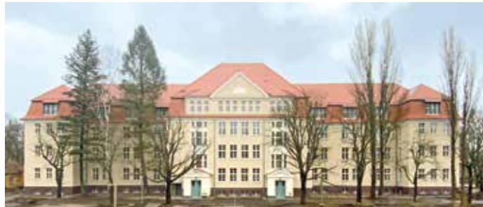
Die neue Vorderansicht des ehemaligen Mannschaftsgebäudes der Infanterieschule
