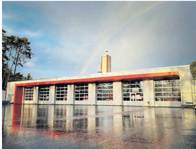
Bei einem der letzten Regengüsse in Zossen ist den Kameraden der Feuerwehr Wünsdorf dieser besondere Schnapsschuss gelungen. Das Bild zeigt die mittlerweile bereits fertiggestellten Anlagen der Feuerwehr. Foto: Feuerwehr Wünsdorf
