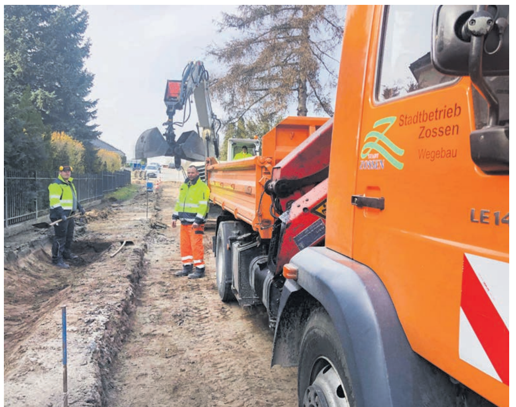
Mitarbeiter aus dem Team Tiefbau des Stadtbetriebes erneuern die Straße „An den Pferdekoppeln“. Hier war es in der Vergangenheit immer wieder zu „Überschwemmungen“ und zu Straßensperrungen gekommen.
