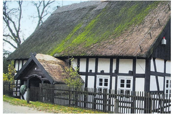
Das Heimatmuseum „Alter Krug“ ist zur Zeit geschlossen. Mit den Sanierungsarbeiten wird in den nächsten Wochen begonnen.
