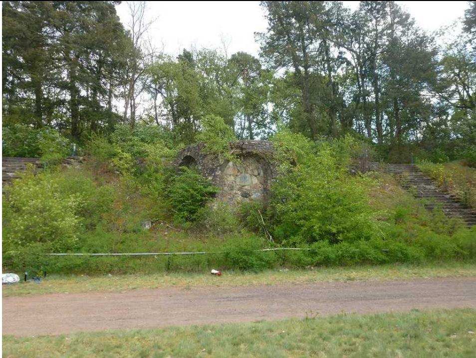
Abb. 5: Treppenaufgänge zum Stadionwall im Süden; in der Mitte Aussichtsplattform; Foto Rebele 05.05.2020
