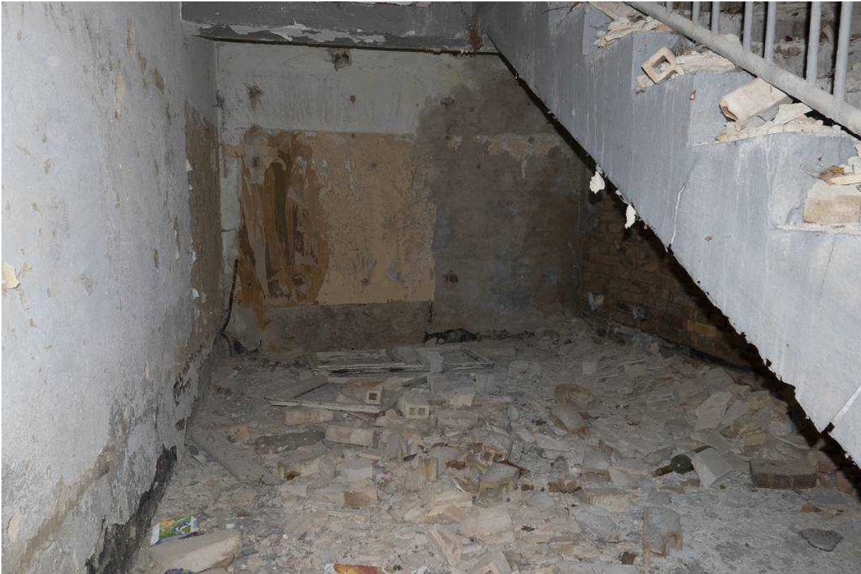
Abbildung 4 Fundpunkt Mopsfledermaus (Mauerwerk unter Treppe in Gebäude 2)
