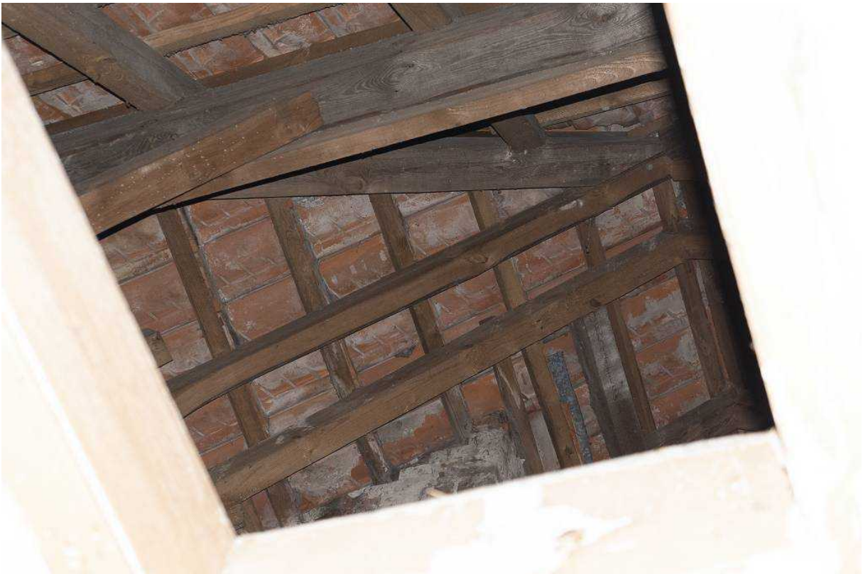
Abbildung 9 Blick in Dachboden (Gebäude 3)
