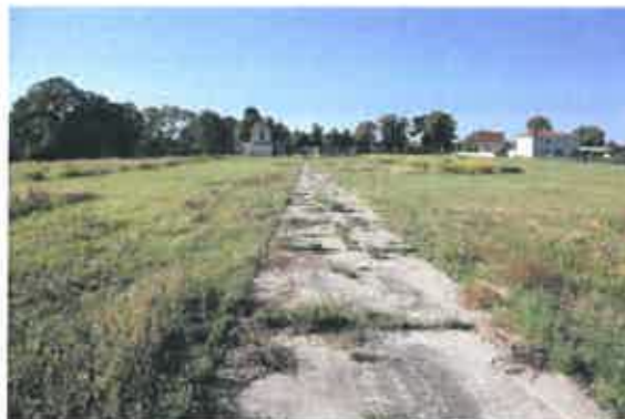
Abbildung 3: Nördliches UG - Blick nach Süden
