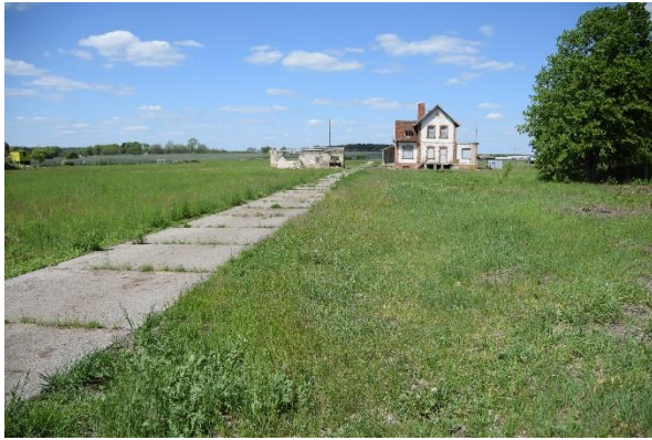
Abbildung 2: Südliches UG - Blick nach Norden
