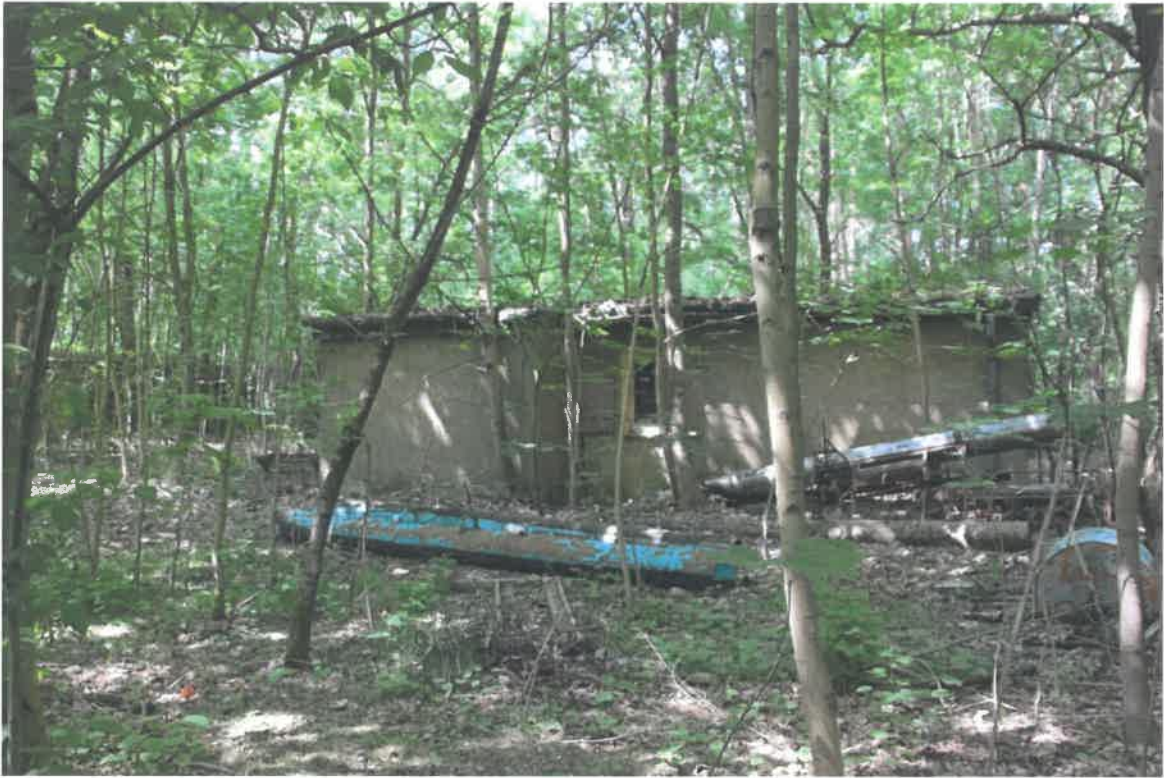
Abbildung 5 fast verfallener Bungalow und diverse Müllablagerungen
