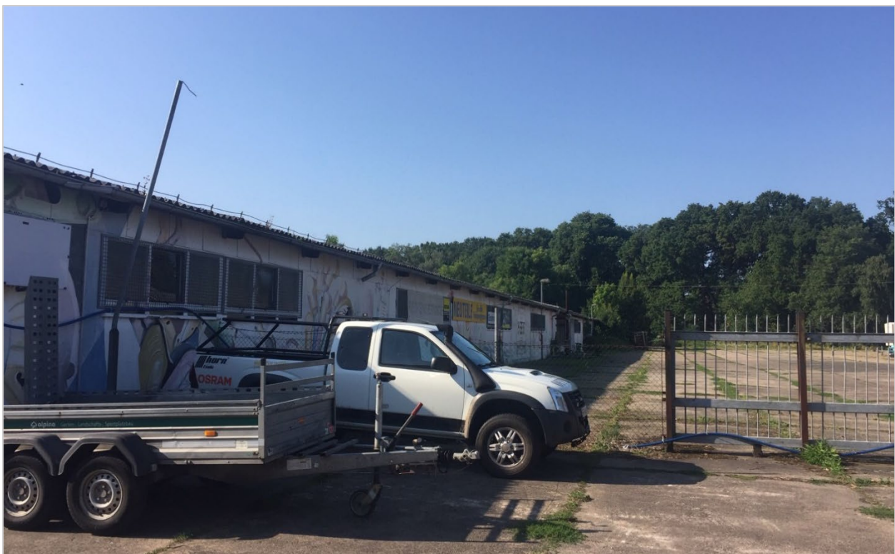
Abbildung 13: Lagerhalle, Quelle: eigenes Foto, 13.08.2021
