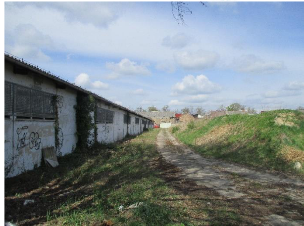
Abbildung 4: Lagerhalle mit Erdaufschüttung
