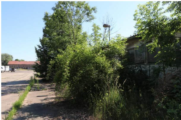
Abbildung 5: Lagerhalle, Sukzession und Betonplatten
